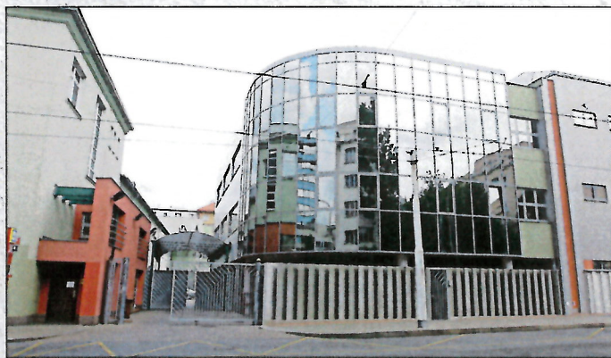
» Budova výrobního závodu III Státní tiskárny cenin, Na vápence 14, 130 00 Praha 3
